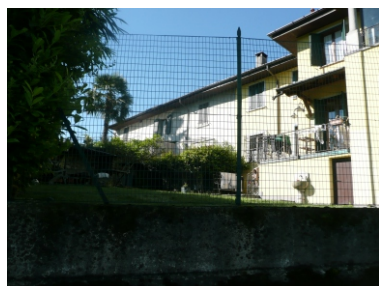
FOTOGRAFIA EDIFICIO (fronte Est)
