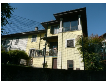
FOTOGRAFIA EDIFICIO (fronte Est)
