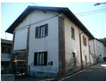
FOTOGRAFIA EDIFICIO (fronte Est)
